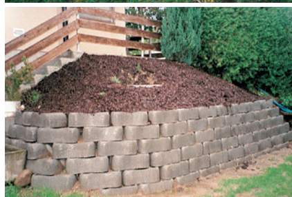
Möglichkeit bei geringen Platzverhältnissen
